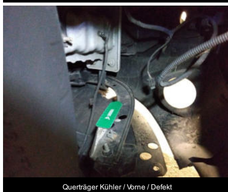
Querträger Kühler / Vorne / Defekt
