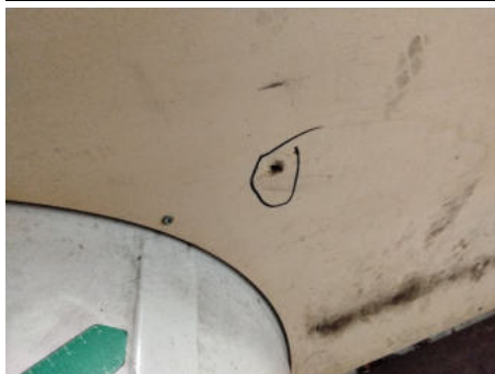
Innenverkleidung Laderaum / Rechts / Defekt
