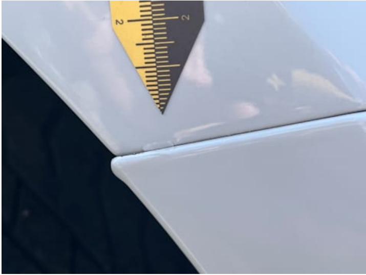
Kotflügel vorne rechts (Lackschaden)
