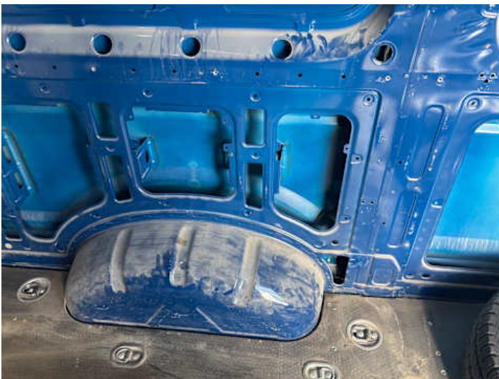
Innenraum (Diverse Schäden)
