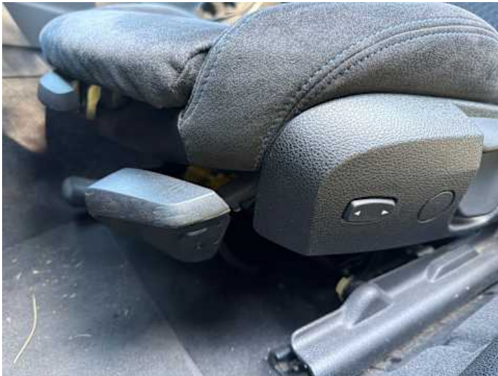
Innenraum (Verschmutzung, Verschleiß, Kratzer, Brandloch)
