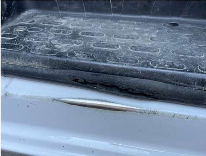
Schweller links (Riss/Bruch)
