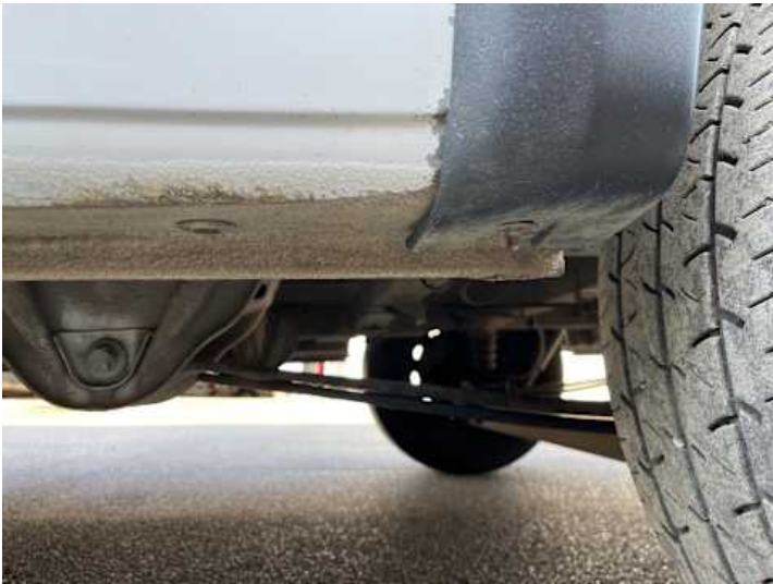
Schweller links (Rost)
