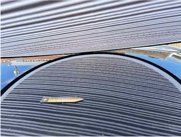
Dach (Lackschaden)
