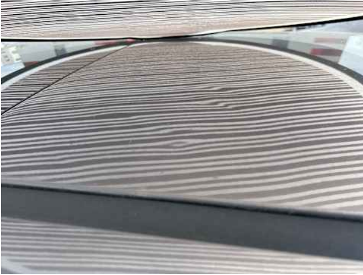
Dach (Verformung)
