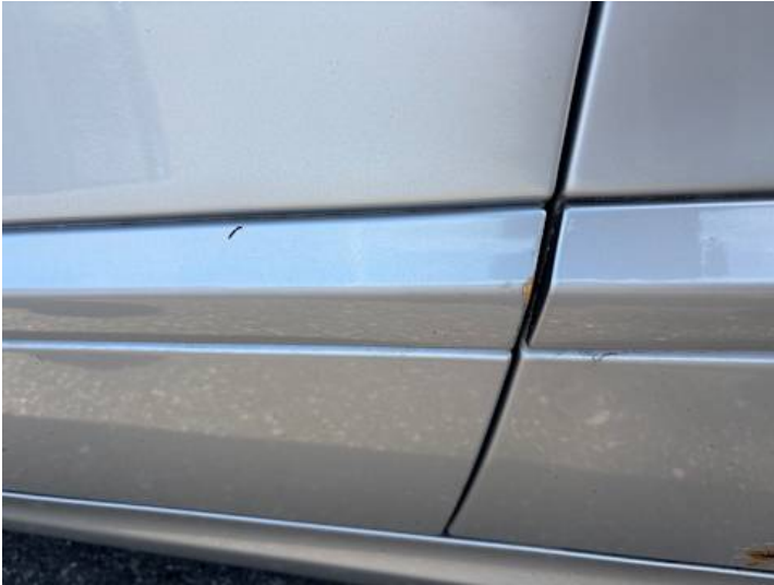
Fahrtür (Lackschaden, Rost)
