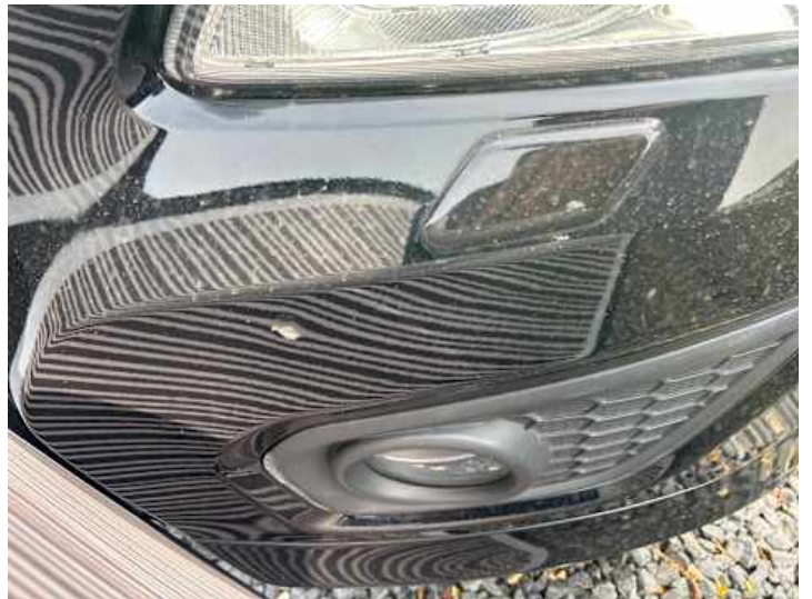
Stoßstange vorne (Delle)
