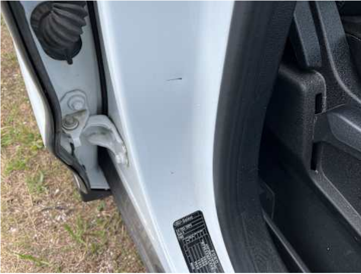
Schweller rechts (Kratzer)
