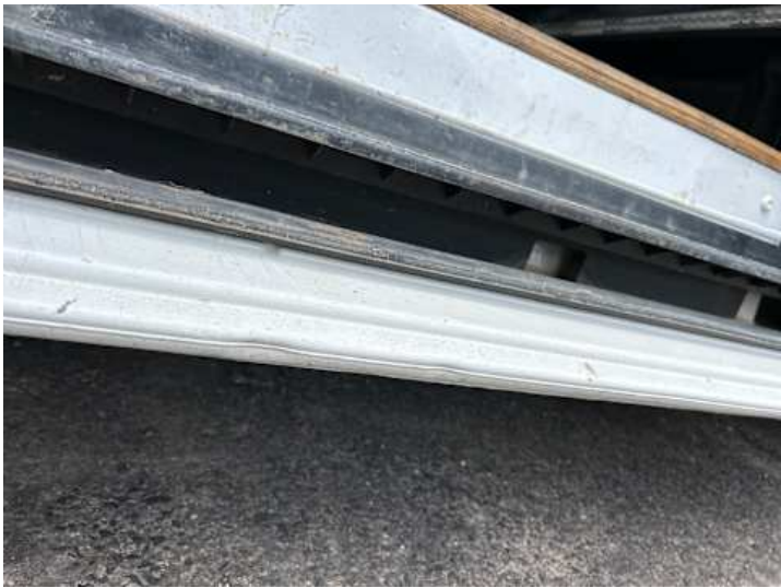
Schweller rechts (Delle)
