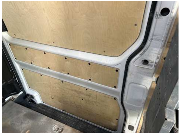
Innenraum (Verschleiß, Diverse Schäden)
