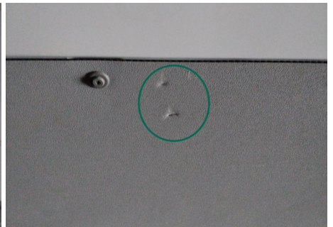
Innenverkleidung Laderaum / Unten Vorne Rechts / Gebrochen
