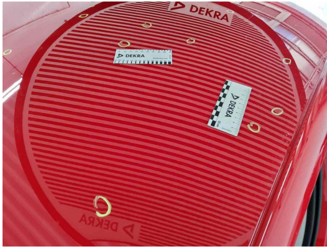
Dach, mehrfach eingedellt, drücken (DEKRA)
