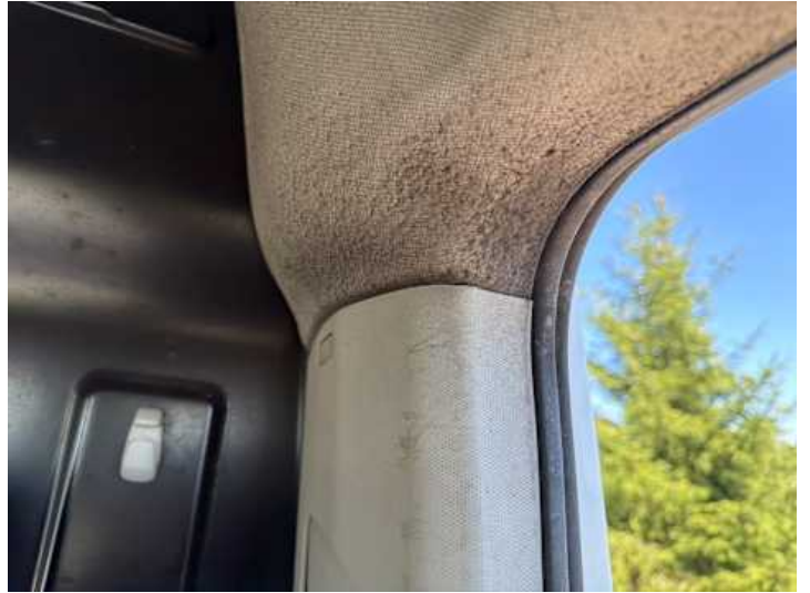
Innenraum (Verschmutzung, Verschleiß, Kratzer, Riss/Bruch, Brandloch)
