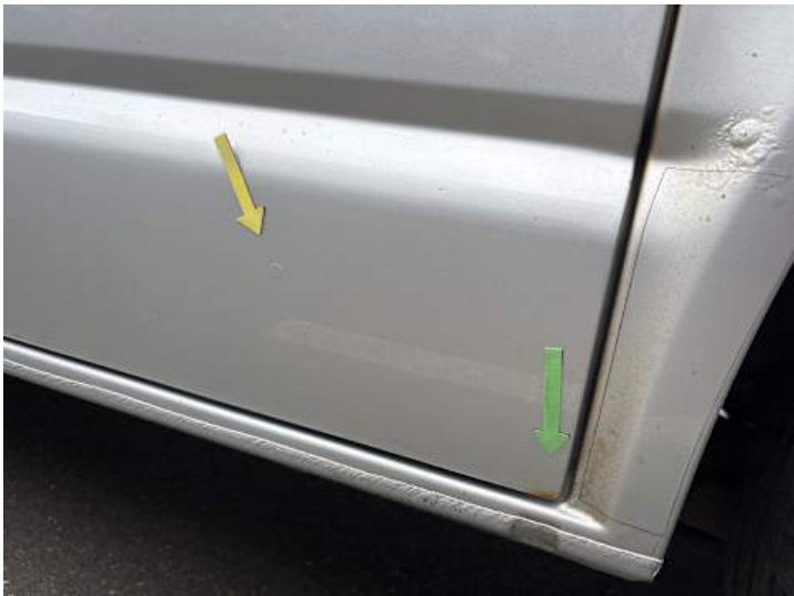
Türe hinten links (Rost)
