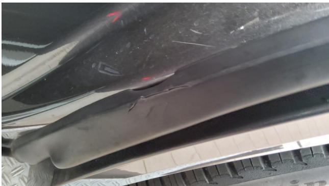
Dichtung Einstieg HL eingerissen ern.
