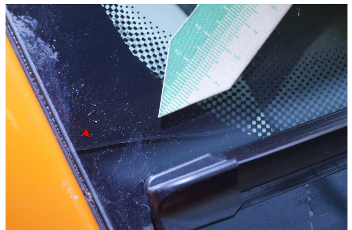
Bild 18: Außen, Frontscheibe, gerissen, erneuern
