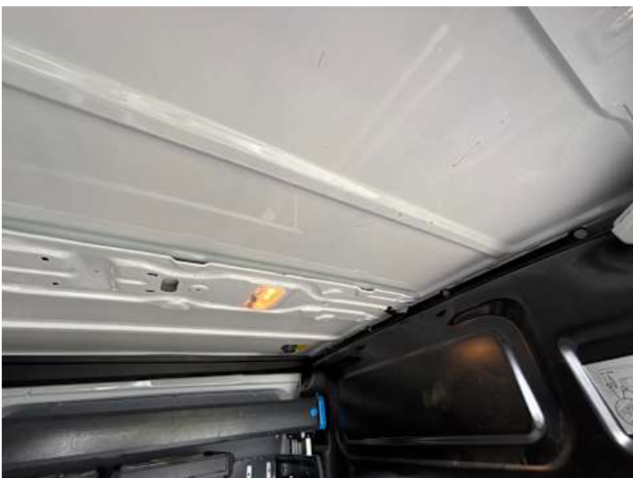
Innenraum (Diverse Schäden)
