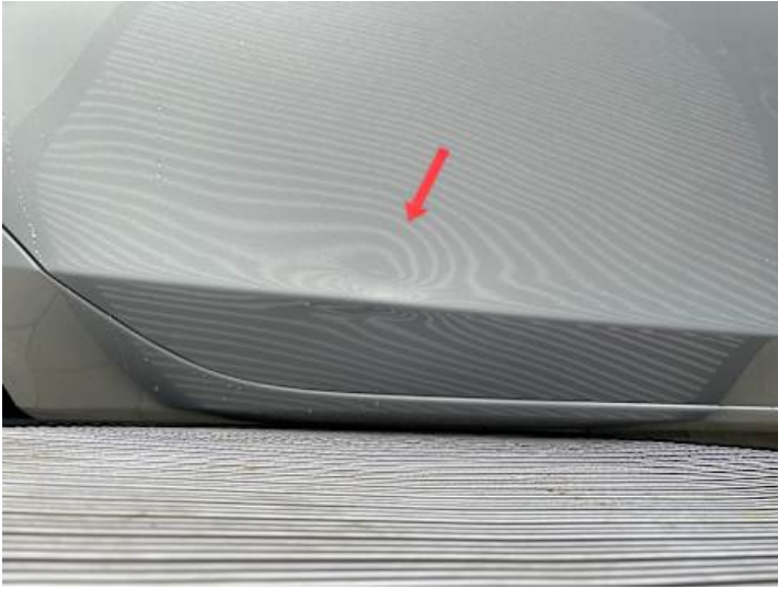
Türe hinten rechts (Verformung)
