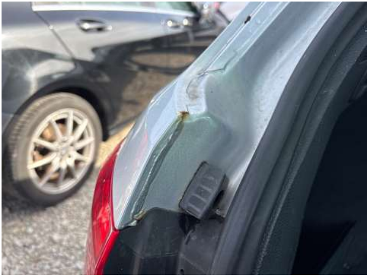
Seitenteil hinten links (Rost)
