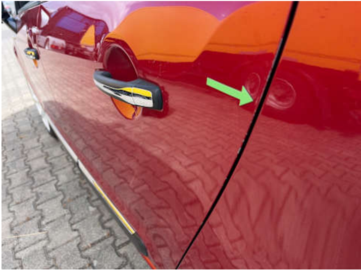
Türe hinten links (Lackschaden)
