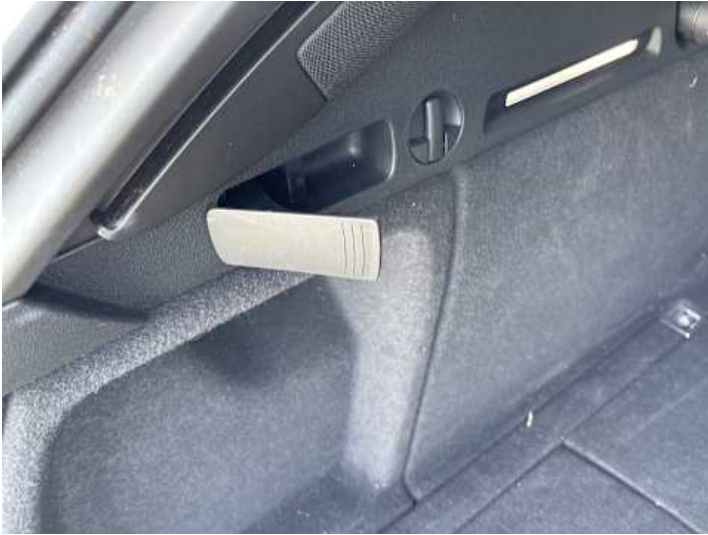
Innenraum (Riss/Bruch, Anderer Schaden): Hebel ohne Funktion
