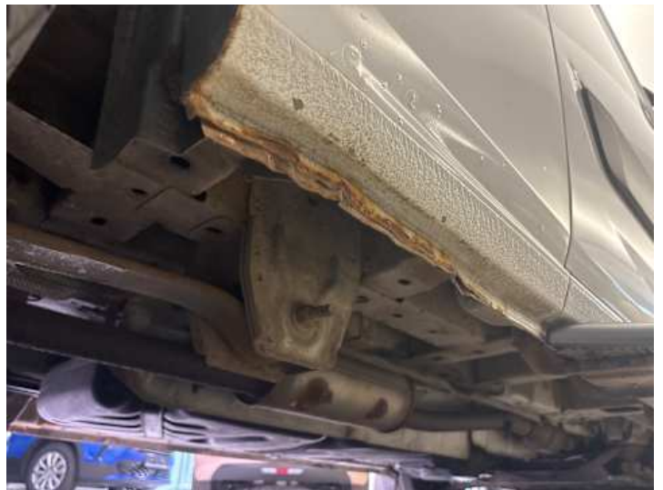
Schweller rechts (Lackschaden, Rost, Verformung)
