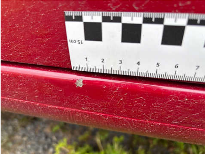
Schweller rechts (Lackschaden)
