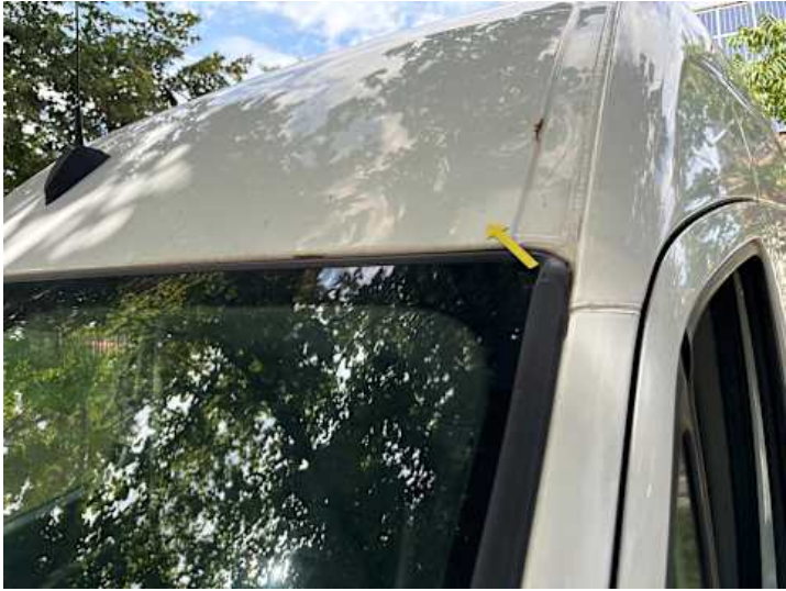
Dach (Verformung, Rost)
