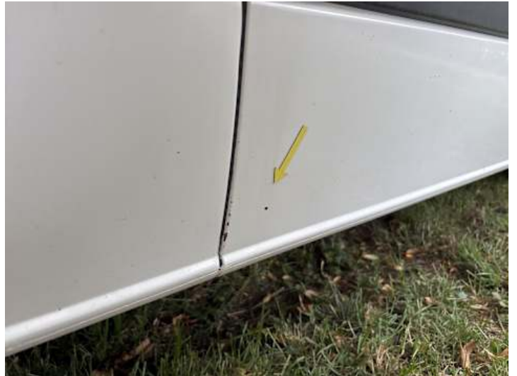
Seitenteil hinten links (Rost)
