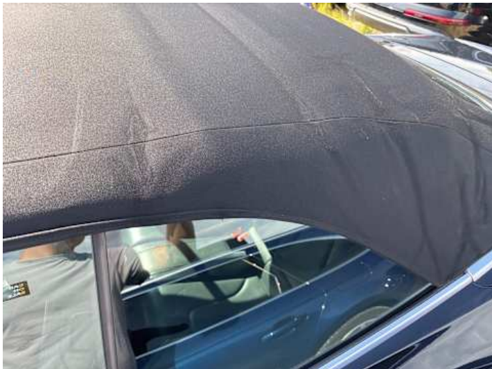
Dach (Anderer Schaden): Genereller Schaden
