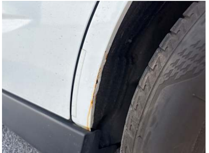
Seitenteil hinten links (Rost)
