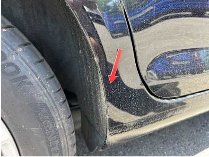
Seitenteil hinten rechts (Rost)
