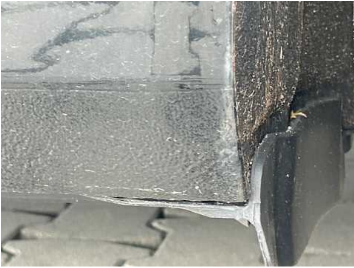
Schweller links (Rost)
