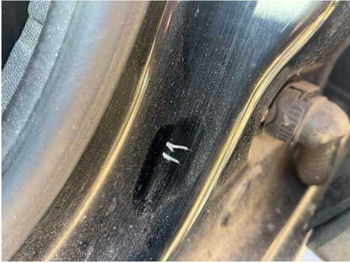
Schweller links (Kratzer)
