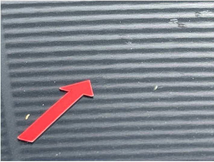
Dach (Lackschaden)
