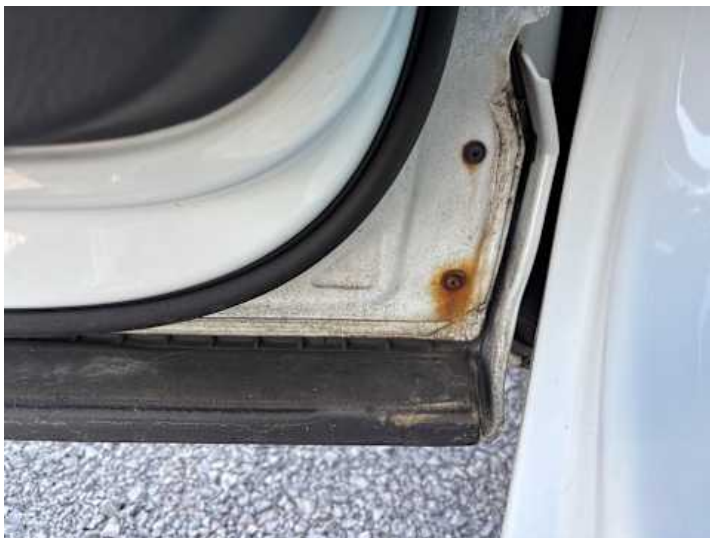
Türe hinten links (Rost)
