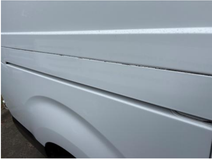
Seitenteil hinten rechts (Unsachgemäß instand gesetzt)
