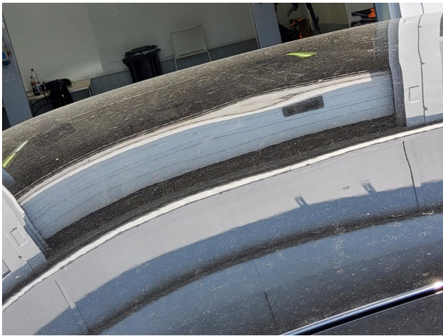
Dach - Instands. und lackieren
