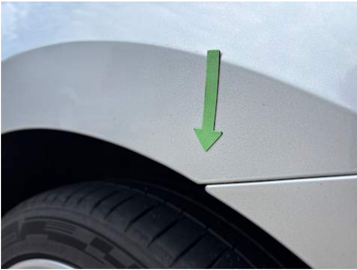
Seitenteil hinten links (Rost)
