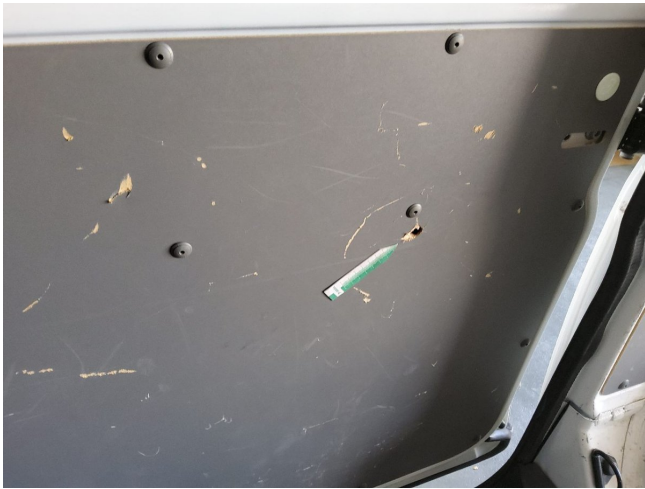
Schiebetürverkleidung beschädigt (DEKRA)
