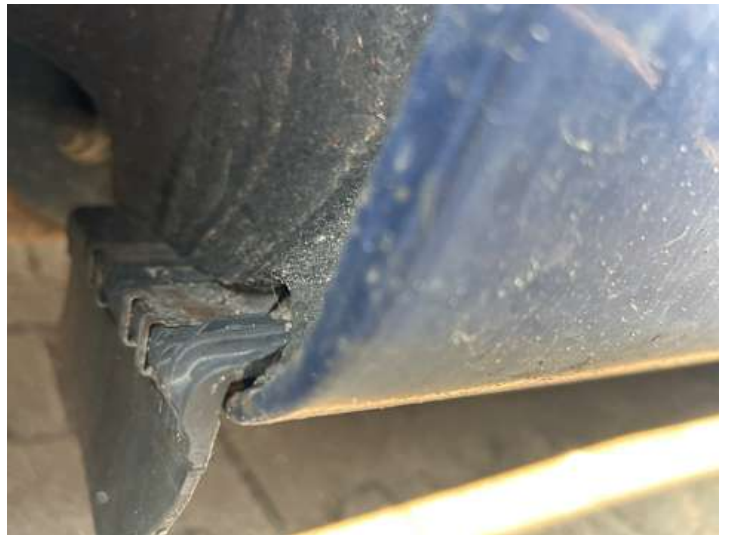
Schweller rechts (Rost)
