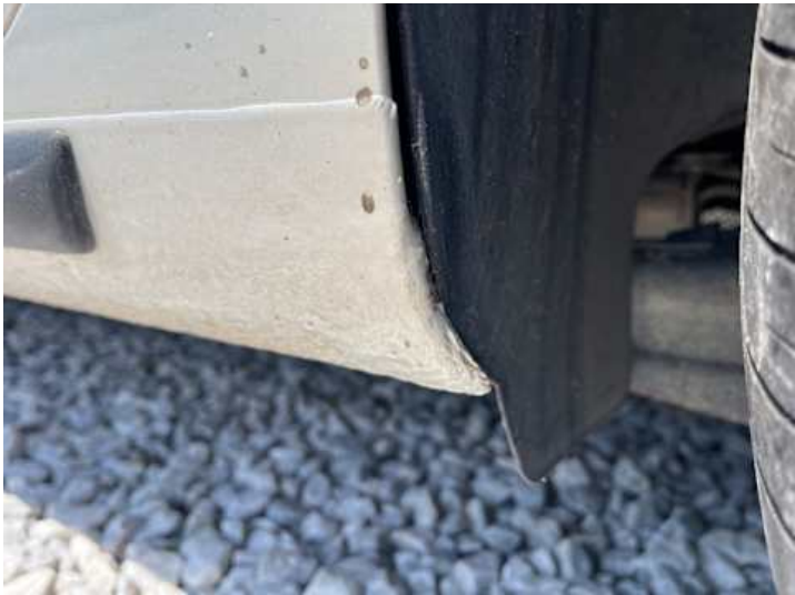
Schweller links (Rost)
