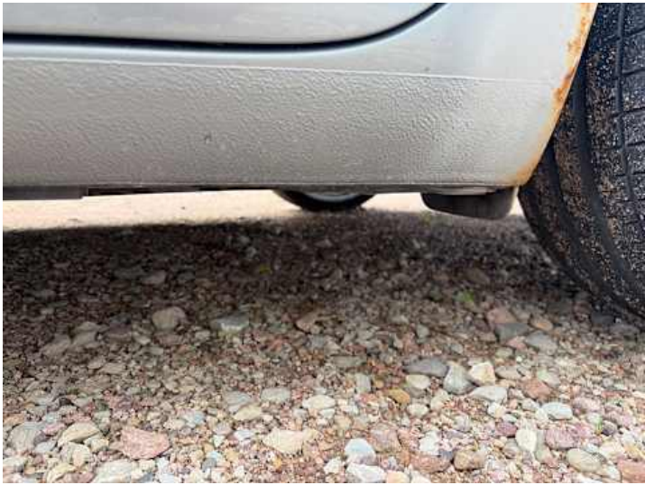
Schweller links (Rost, Lackschaden)
