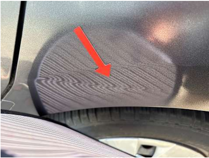
Seitenteil hinten links (Verformung)
