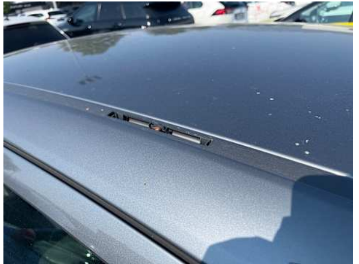
Dach (Anderer Schaden): Fehlteil
