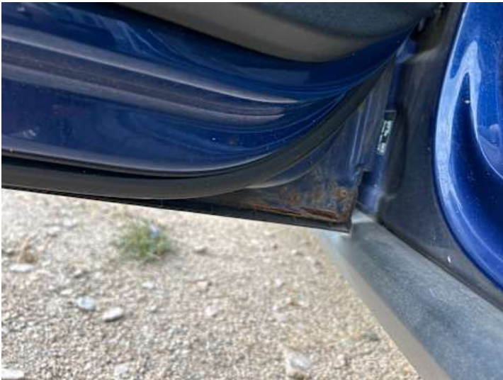
Türe hinten links (Rost)
