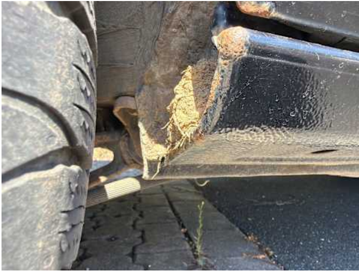
Schweller rechts (Rost)
