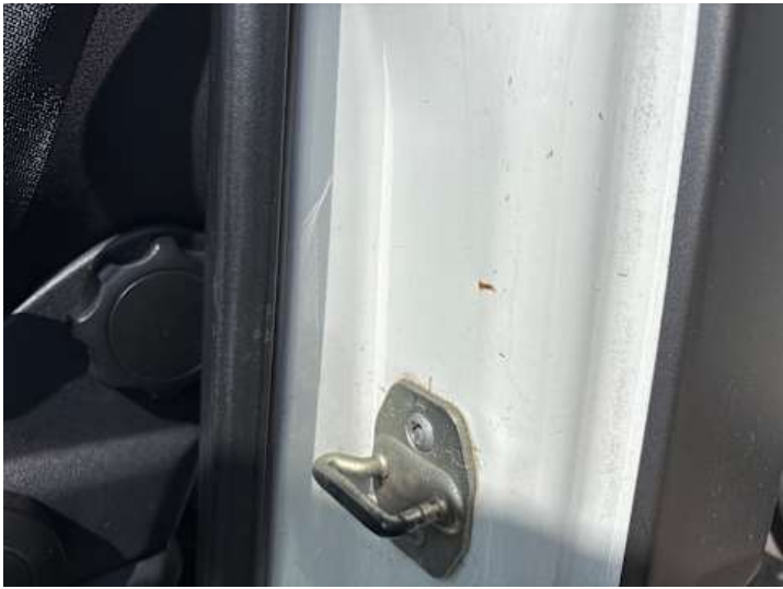
Schweller links (Rost)
