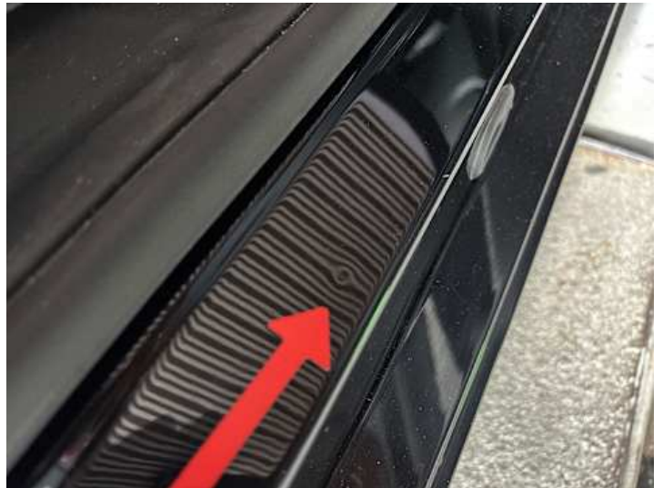
Schweller rechts (Delle)
