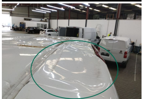
Dachholm / Hinten / Delle
