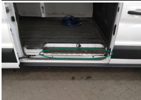
Holzboden / Rechts / Abgewetzt
