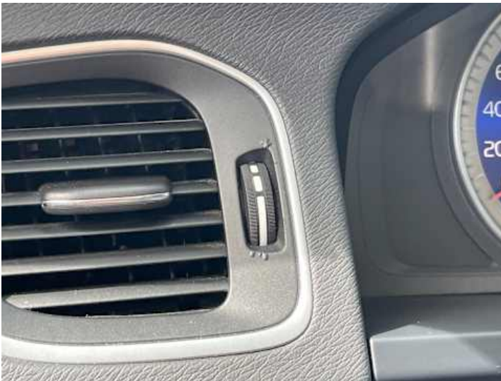
Innenraum (Verschleiß, Diverse Schäden)
