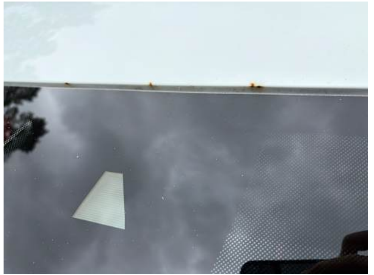
Dach (Lackschaden, Rost)
