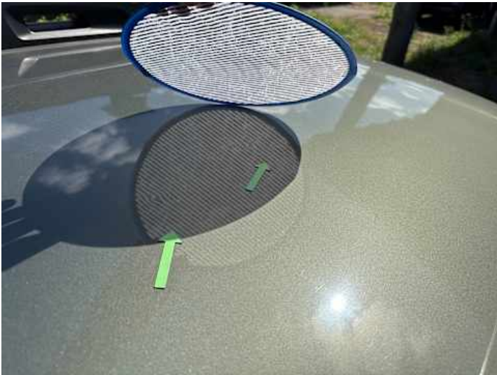
Dach (Delle, Anderer Schaden): Hagelschaden
