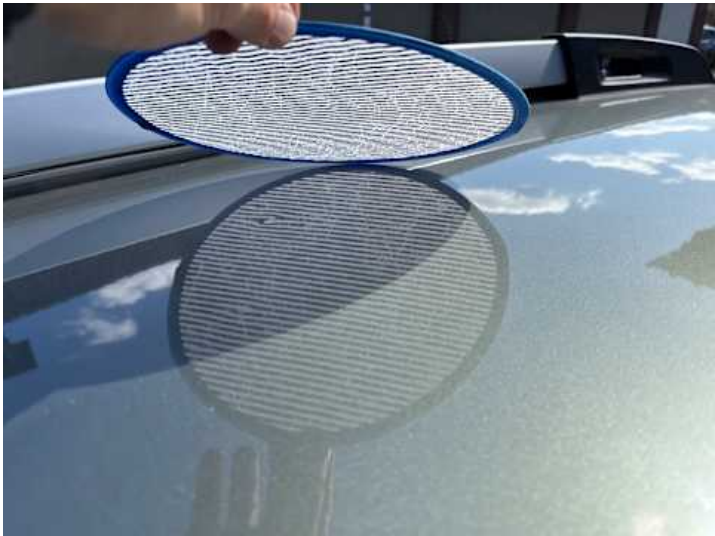
Dach (Delle, Anderer Schaden): Hagelschaden
