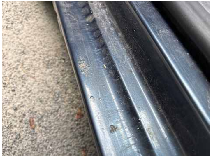
Schweller links (Rost, Verformung)
